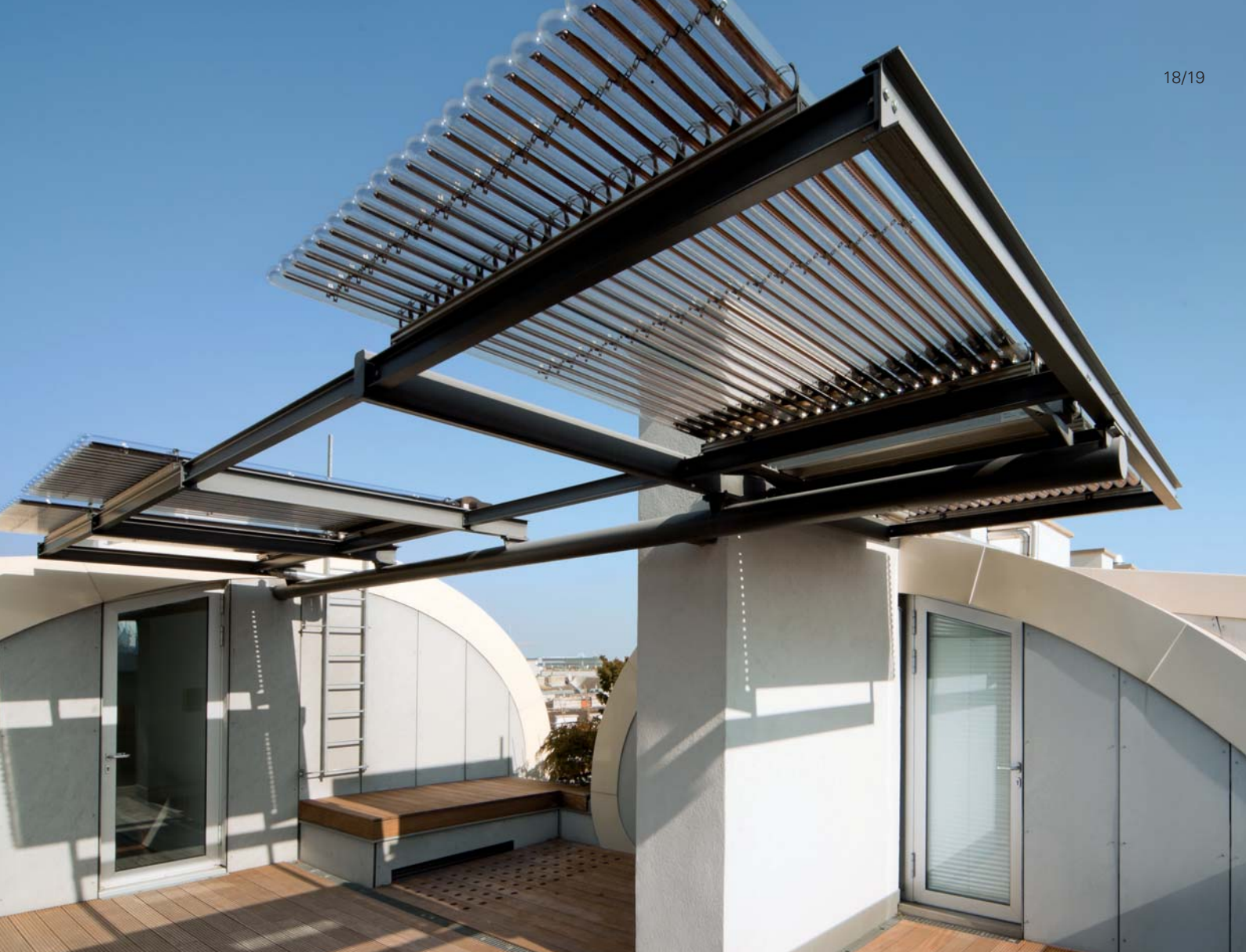
Beispiel für den Einsatz von Vitosol 200-T Röhrenkollektoren
