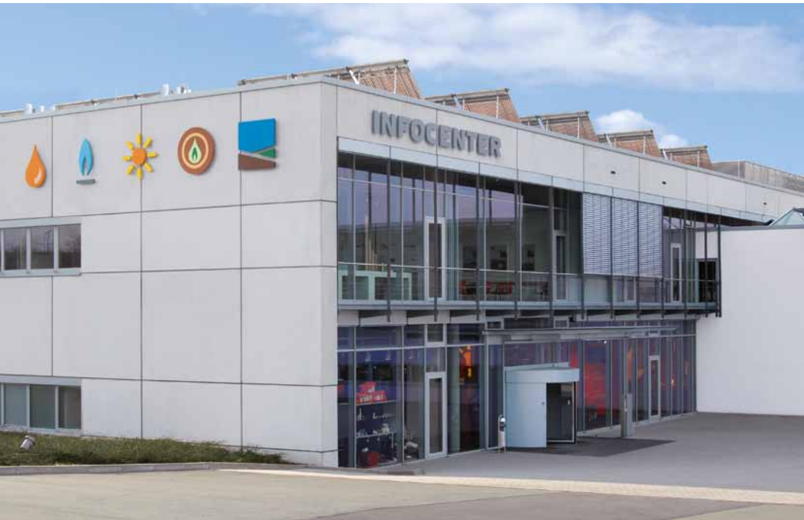
Die Energiezentrale und die Viessmann Akademie in Allendorf
