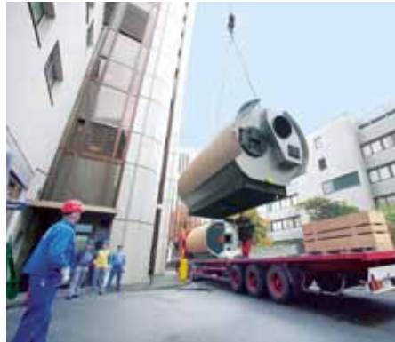
Anlieferung eines Vitomax Kessels auf der Baustelle
